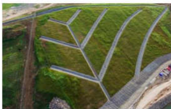
Рис. 8. Осушение оползневого склона
