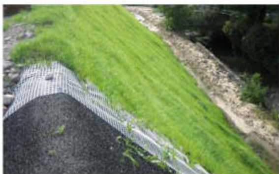
Рис. 7. Укрепление склона травянистой дернообразующей растительностью
